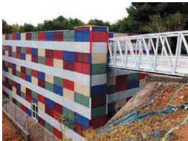
▲ Nuevo aulario modular al que se accede por la planta superior, 2011.
