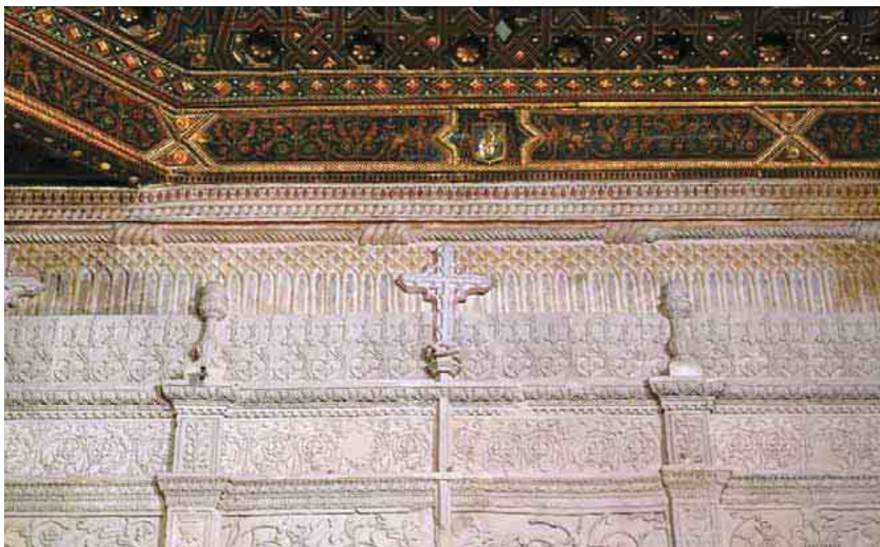
▲ Franja de pintura mural recuperada entre el artesanado y la crestería de las yeserías de la Capilla de San Ildefonso.
