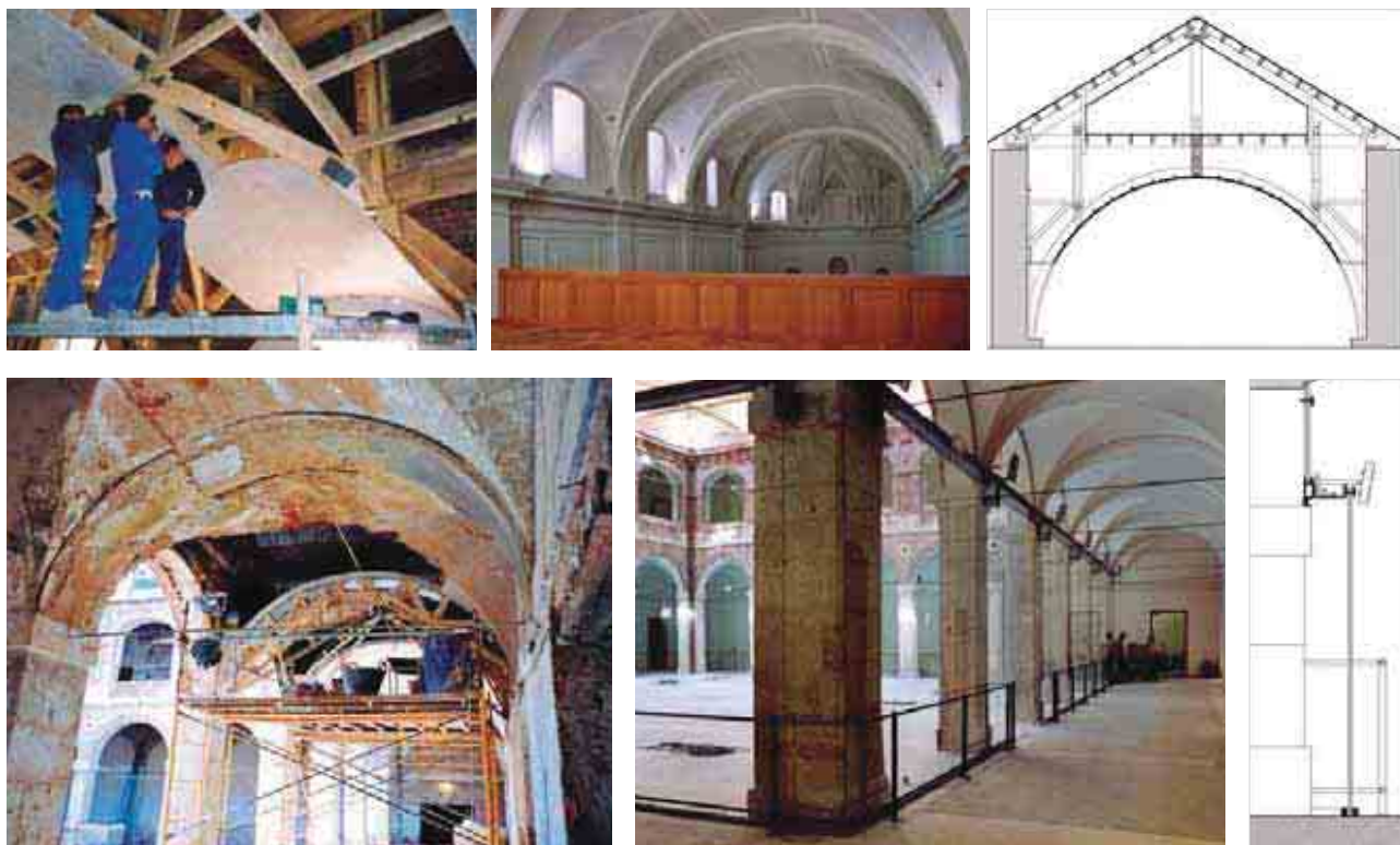
▲ Nueva bóveda encamionada que recupera el espacio interior de la iglesia y bóvedas de crucería parcialmente reconstruidas en el claustro, ambas en el Convento del Carmen Calzado.
